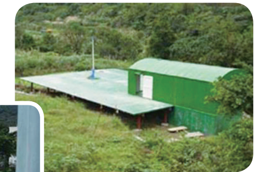
電磁輻射測試之 10 米開放測試場
